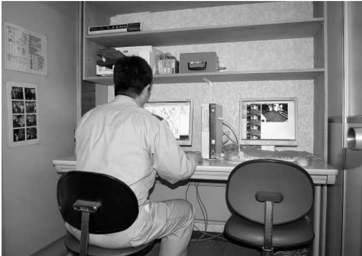
松栄ガスの監視ルーム。左のPCで各種センサー、右のPCでカメラを監視している
